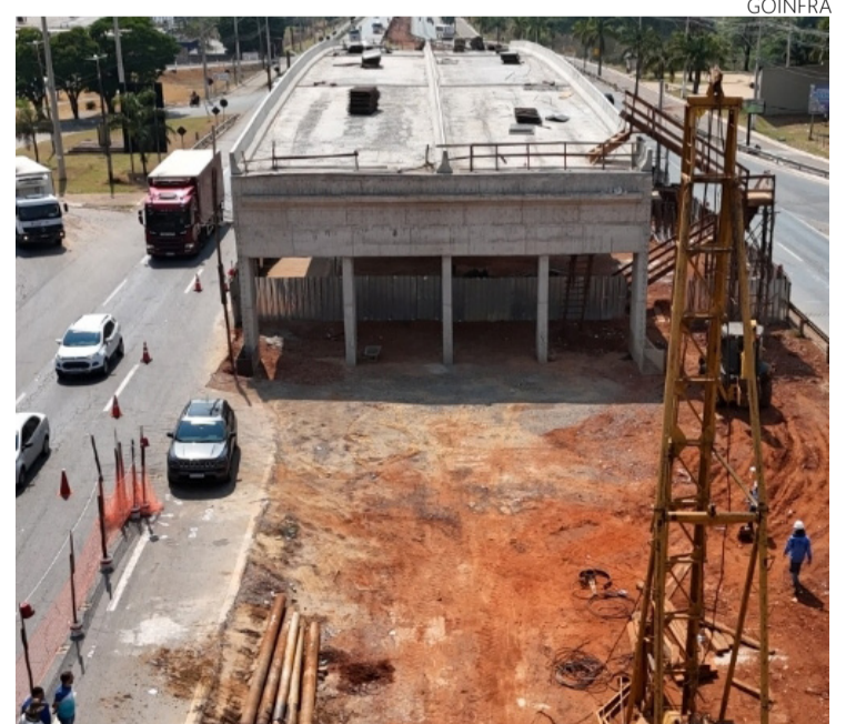
Goinfra executa reforço do solo na Rodovia dos Romeiros: obra será finalizada em 2025
